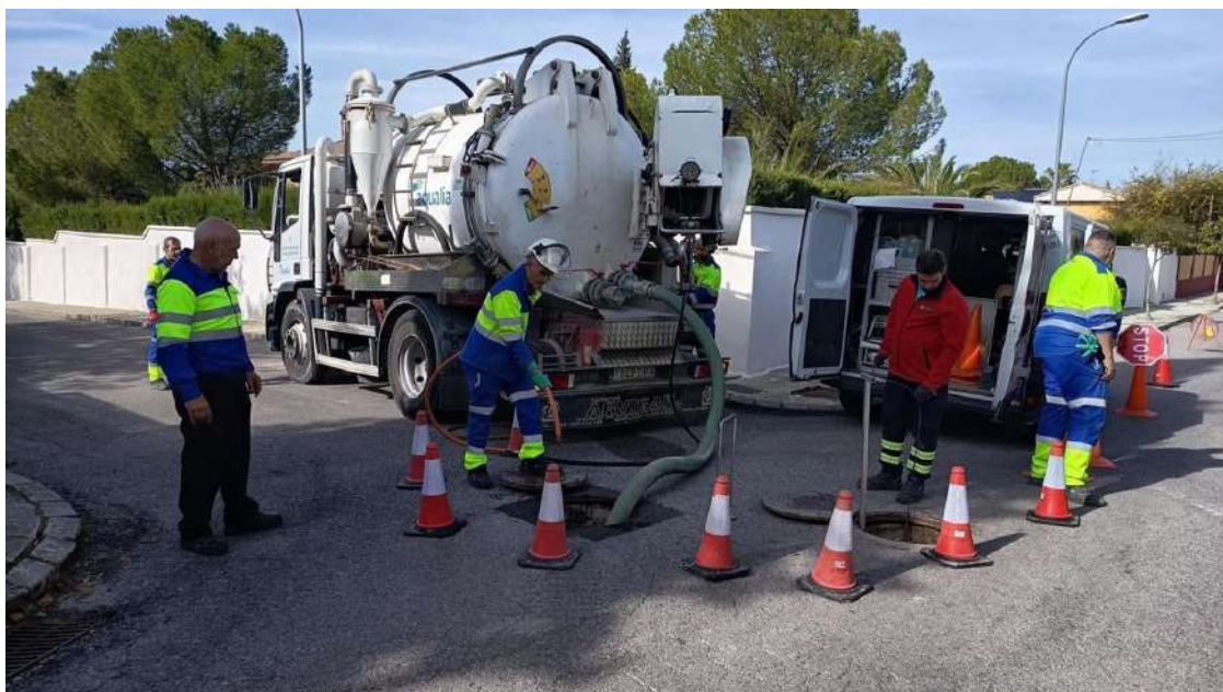
Juan Antonio Gómez, a la izquierda, supervisa los trabajos en el Puente Tablas.
