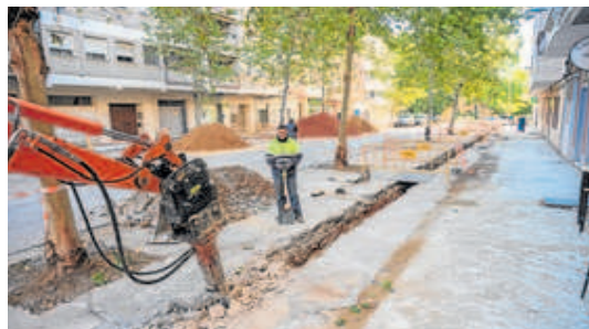
Las obras en la plaza de Portugal. J. V. ARNELAS
