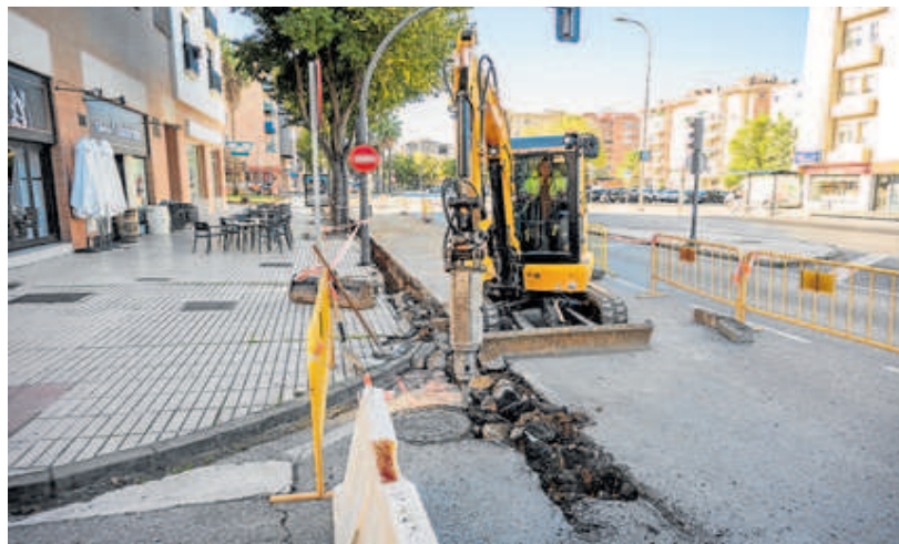
Obra de cambio de tuberías y acerado en María Auxiliadora. J. V. ARNELAS
