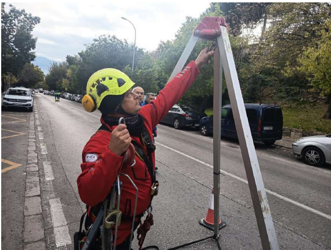
Un operario instala la polea en el trípode de seguridad.
