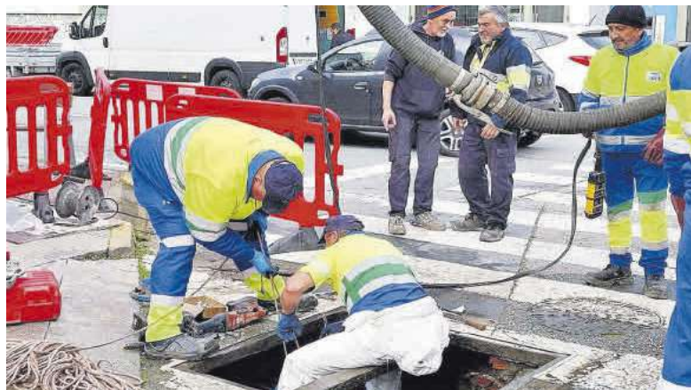
Operarios trabajando esta semana en el cruce entre Montero Ríos y Eduardo Vincenti. | S.Alvarez
